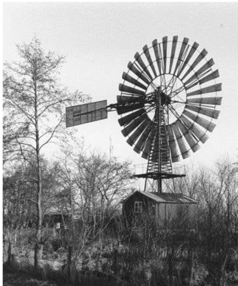
Afbeelding 18: Een Amerikaanse windmolen. Deze molen heeft jarenlang het overvloedige polderwater uit de waterschapspolder De Hege Warren gepompt.
